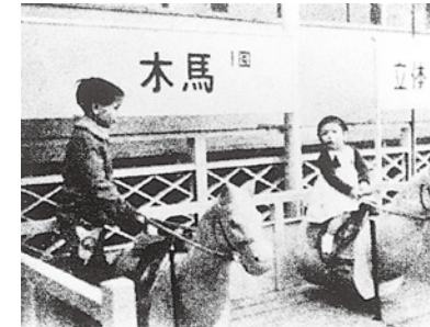
横浜の百貨店屋上に設置された2台の「木馬」
