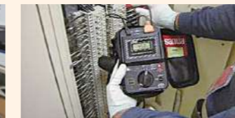
直営アミューズメント施設での電気設備点検
