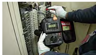
直営アミューズメント施設での電気設備点検
