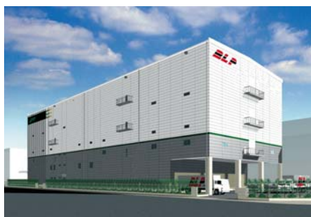
働く人にやさしい作業環境を目指し、高品質・高付加価値を提供できる関西の拠点として、2008年5月に稼働予定の新倉庫（大阪府茨木市）。
