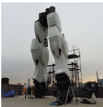
実物大ガンダムの工事の様子 (2009年5月中旬撮影)
