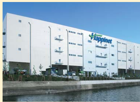
■ハピネット東日本第二ロジスティクスセンター 所在地: 千葉県船橋市西浦3-10-4 敷地面積: 約18,183㎡ 延床面積: 約28,151㎡
