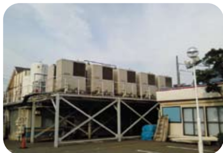
コージェネレーションシステム
