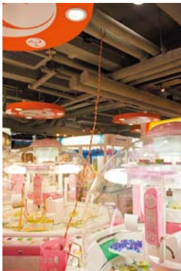
天井部にまとめられた配線コード
