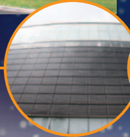
壁面に設置された 太陽光パネル
