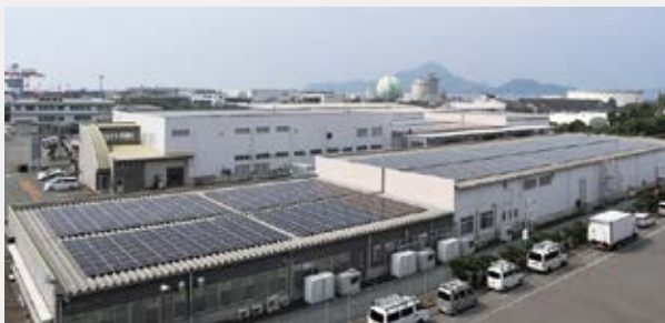
(株)ハートの本社工場
