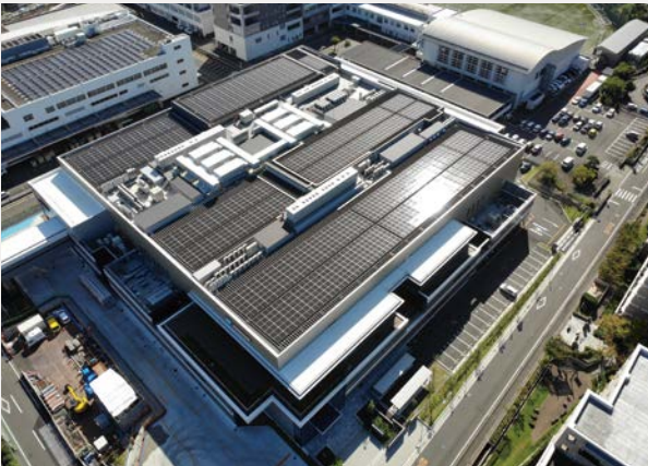
BHCPDIIの太陽光発電パネル
