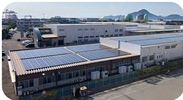
ハートの太陽光発電設備
